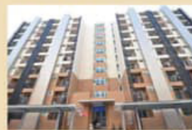
หอพัก มฉก.2 ห้องแอร์
